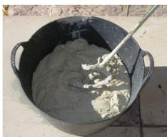
Mélanger 25 kg (1 sac) **Cemcol SD** à 6- 7 litres d'eau claire jusqu'à obtenir une pâte homogène et sans grumeaux.
