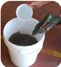
Mélanger les 2 composants (4 pour 1 d'endurcisseur) au mitigeur à lente rotation jusqu'à obtenir une parfaite homogénéisation.
