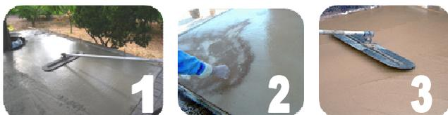
1.- En los minutos que siguen a la regularización del hormigón, este se alisa permitiendo que el agua suba por capilaridad y asegurar un perfecto enganche entre hormigón y mortero.
