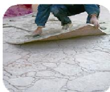
Con el hormigón en estado plástico se espolvorea el **Despi** que actúa como desencofrante y envejecido del pavimento.
