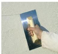
Appliquer la produit jusqu'à obtenir l'épaisseur souhaitée, au minimum 12- 15 mm. Régler et lisser pour obtenir un aspect bien plat.
